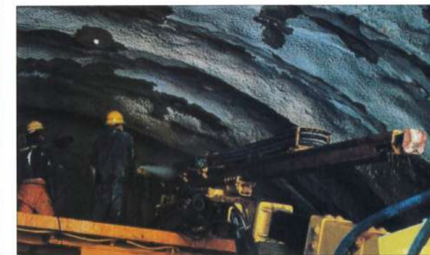
注入式鋼管先受け工法 脆弱地盤でのトンネル施工の補助工法として注入式鋼管先受け工法に使用されています。
