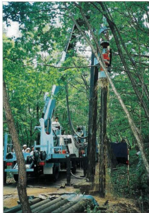
水井戸 SGP管を使用して100m程度(最大250m)の水井戸掘削に使用されています。
